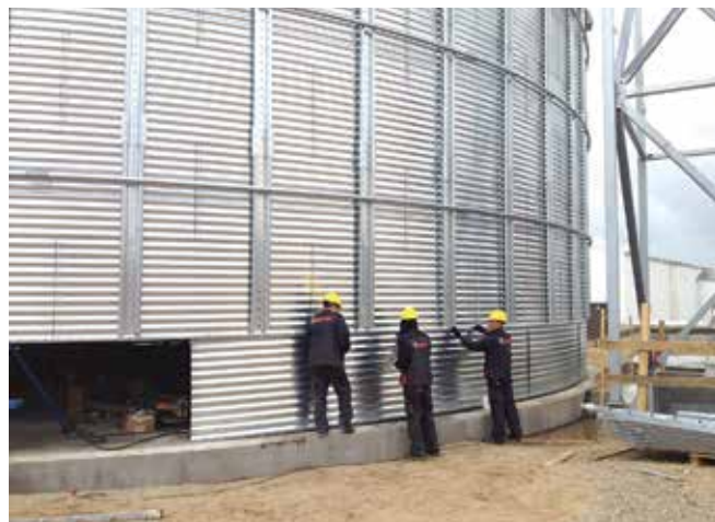
Didžiausio bokšto ir pirmosios bokštinės džiovyklos Danijoje statyba
